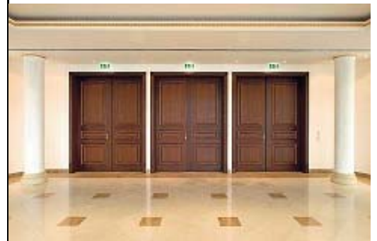
Brandschutztüren müssen nicht zwangsläufig aus Stahl sein. Ebenso sind elegante Edelstahlauführungen, filigranes Aluminium oder wie in diesem Fall Holz möglich. Bild: Herholz
