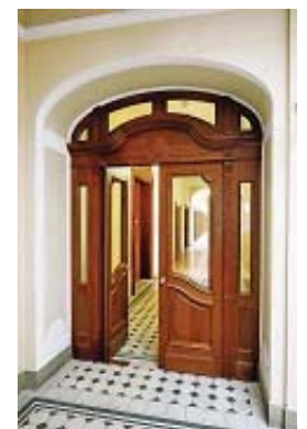
Individuelle, nach Maß angefertigte Brandschutztüren aus Holz ermöglichen angepasste Gestaltungen bei Sanierungen und im Denkmalschutz. Bild: Sturm
