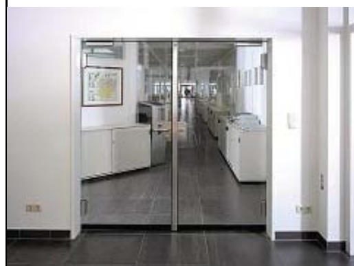
T30-Brandschutz funktioniert auch ohne Rahmen. Die rauchdichte Ausführung wird in diesem Fall mit einer in die Konstruktion integrierten absenkbaren Bodendichtung erreicht. Bild: Teckentrup
