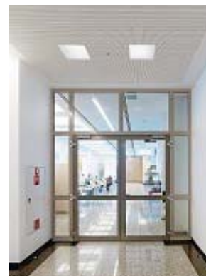
Auch feuerbeständige T90/F90 Brandschutztüren und Wandelemente lassen sich mit hohen Glasanteilen, schmalen Profilsansichten und eleganter Gestaltung ausführen. Bild: Schüco
