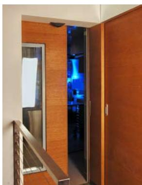
Sturm hier durchgängig flächenbündige T30 Feuerschutz-Türsysteme verbaut. Zarge, Türblatt, Bänder und Schließer fügen sich besonders harmonisch in das Raumdesign ein. Die Blockfutterzarge schließt beidseitig flächenbündig mit der Mauer ab, gerin-
