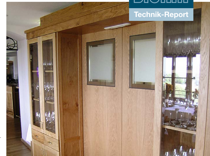
Die erste Sturm T30-1/2 Feuerschutz-Schiebetür mit Automatik-Antrieb im Restaurant der Festung Hohensalzburg: 2-flügelig, Durchgangslichte 1200 mm, vollständig im Vitrinensystem des Innenausbau integriert und in geöffnetem Zustand nicht sichtbar. Mit Oberfläche Eschenfurnier und Klarlack von Sturm direkt zur Montage geliefert. Türantrieb frei programmierbar.
