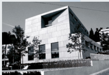
Markante Architektur, Objekt Luzern
